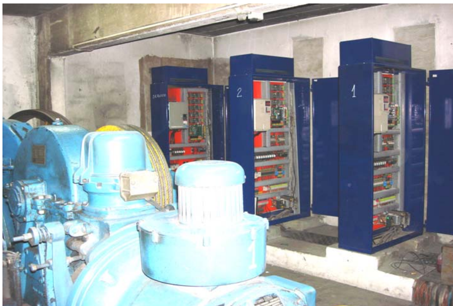
Foto N ° 3 Vista de la sala de ascensores.
