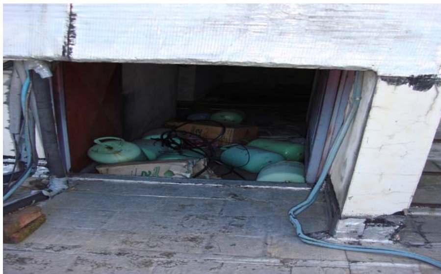
Foto N ° 21 Vista en la azotea debajo del tanque de reserva de agua un depósito de garrafas las que se utilizan para el AA y otros elementos en desuso.
